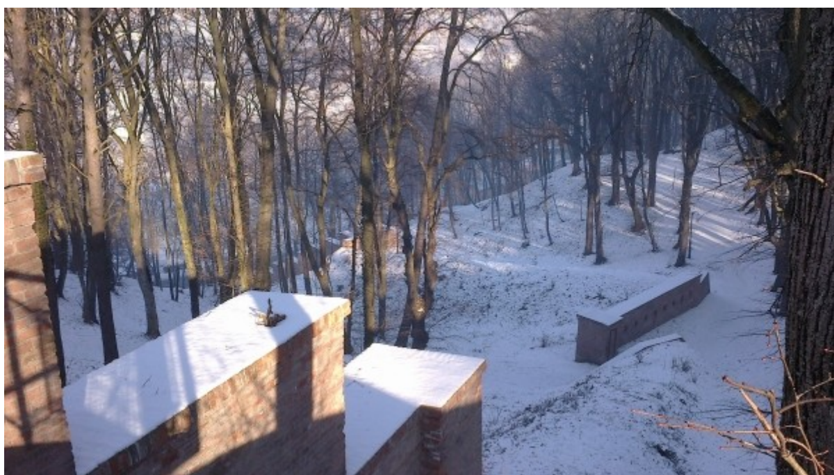
Widok z zachodniej części fortu na Bramę Sanocką Górną i mur dochodzący do ul. Sanockiej
