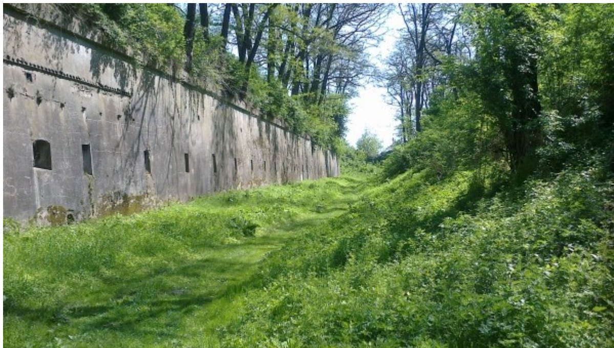
Fosa fortu i galeria strzelecka w przeciwnstoku
