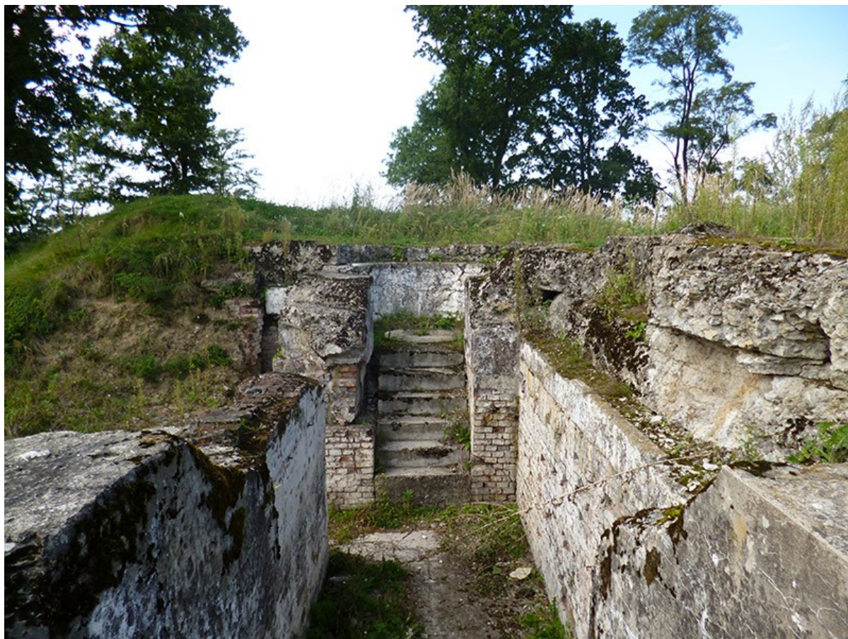
Bateria pancerna - widok na fundamenty lewej podstawy
