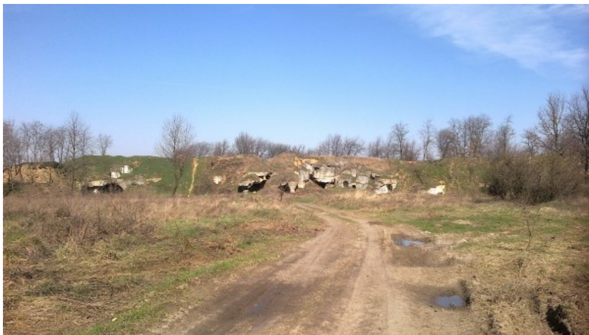
Ogólny widok koszar szyjowych fortu
