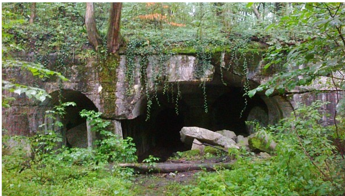
centralna część schronu głównego, wejście do poterny osiowej
